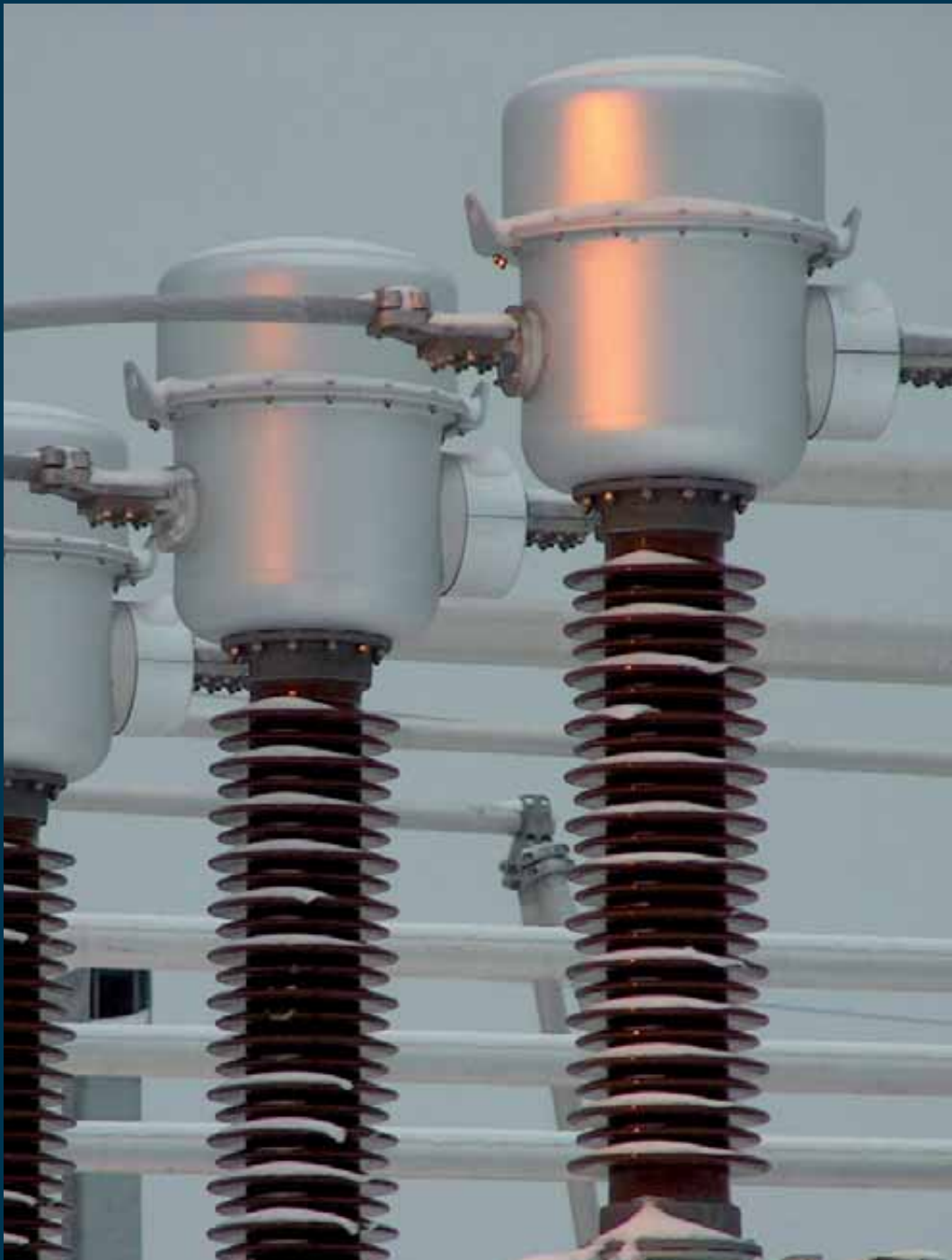
› Transformateurs combinés de 123 kV.
