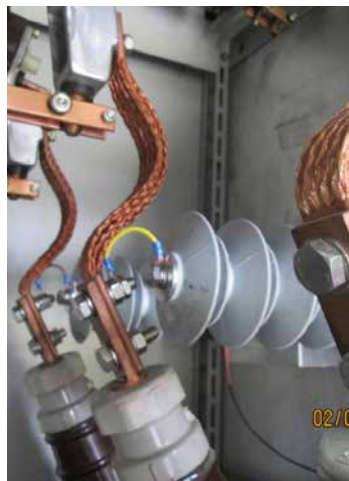
› Senseurs de tension sur appareillage d'isolation d'air
