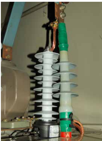
› Senseurs de tension sur appareillage d'isolation d'air
