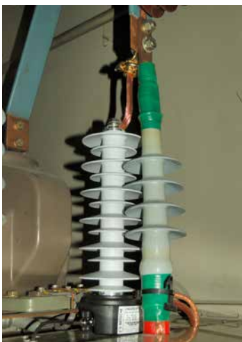
› Sensores de tensión en aparellaje de aislamiento de aire
