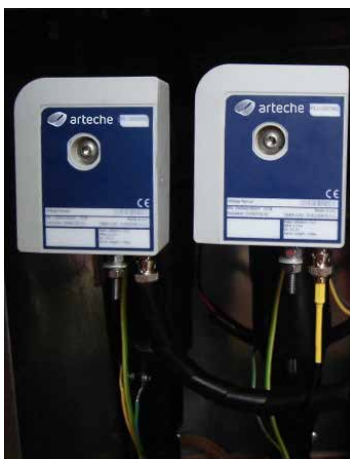
› Sensores de voltaje PLUGSENS Instalados en una celda GIS
