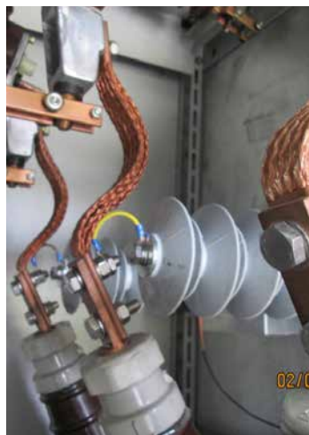
› Sensores de tensión en aparellaje de aislamiento de aire
